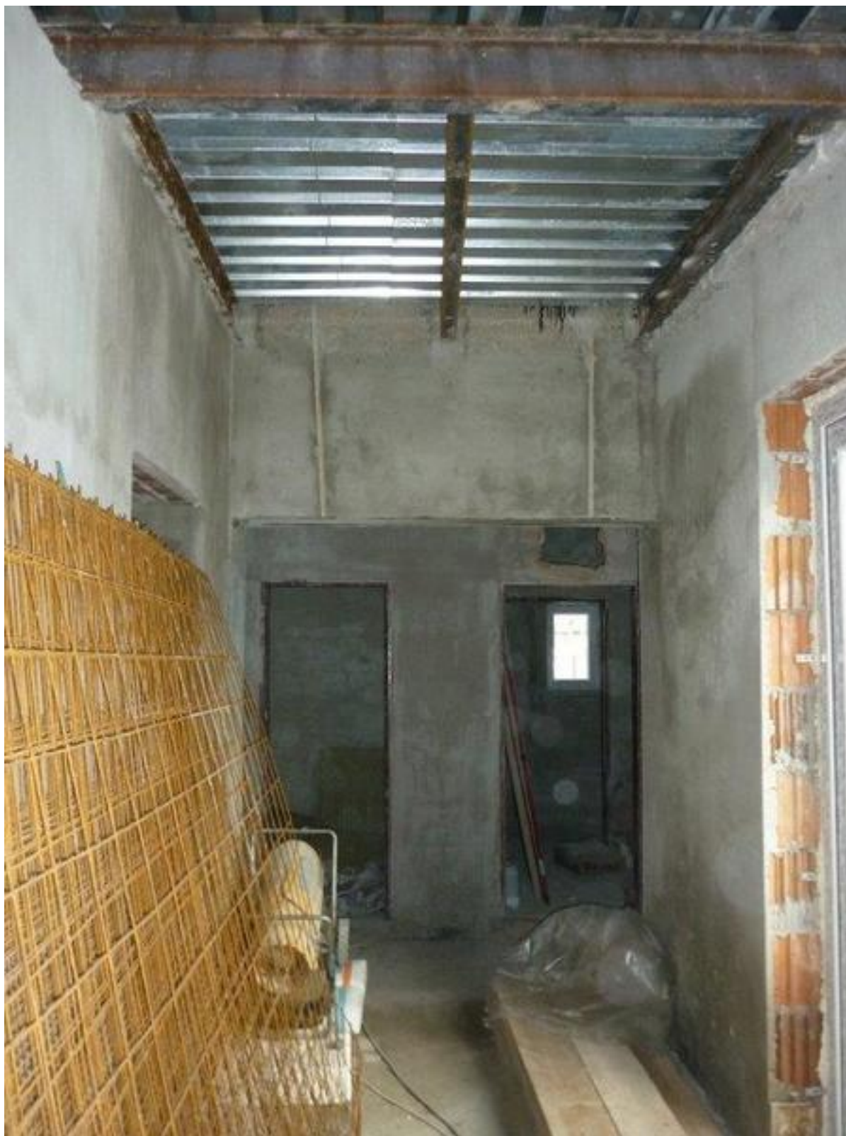
Z rekonstrukce (14. prosince 2015)
