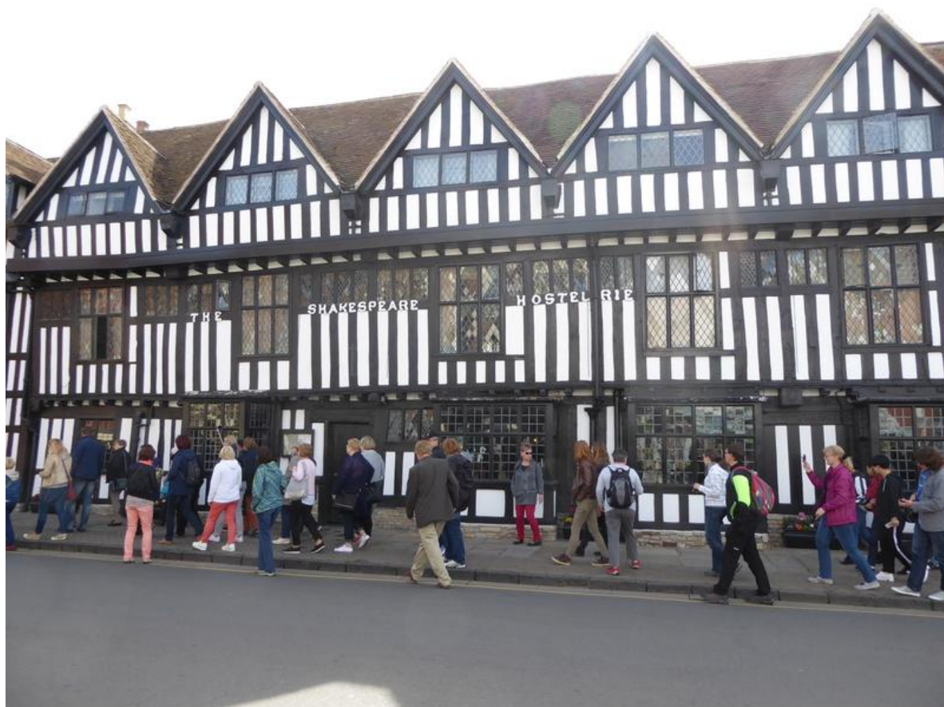
[22] Stratford upon Avon – hrázděné domy_ [22]
